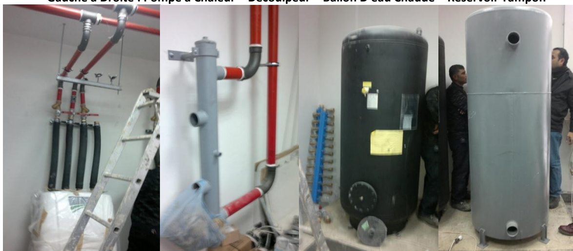
Gauche à Droite : Pompe à Chaleur – Découpleur – Ballon D'eau Chaude – Réservoir Tampon
