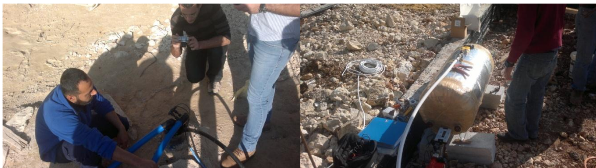
Coulis de Remplissage (Gauche) – Vue Finale du Champ de forage (Droite)
