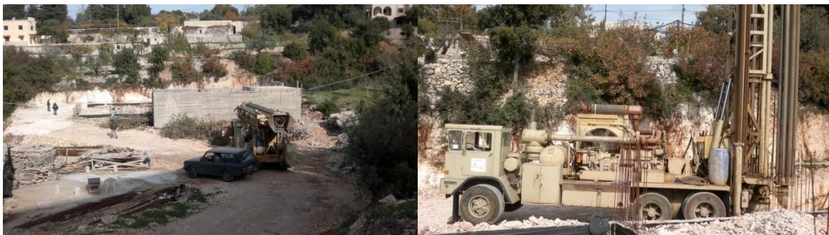
Photo du Site (Gauche) – Machine De Forage (Droite)
