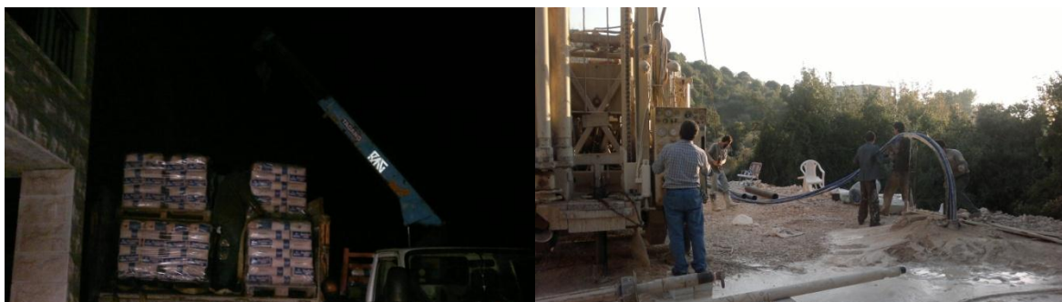
Vue de L'ouverture du forage (Gauche) – Installation du Test Thermique (Droite)
