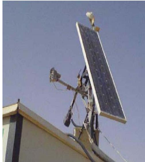
Ces modèles permettent aux traqueurs de suivre le soleil par la rotation autour d'un axe fixe. Au gain solaire optimum, l'angle de cet axe fixe doit être ajusté manuellement sur une base périodique tout au long de la saison.
